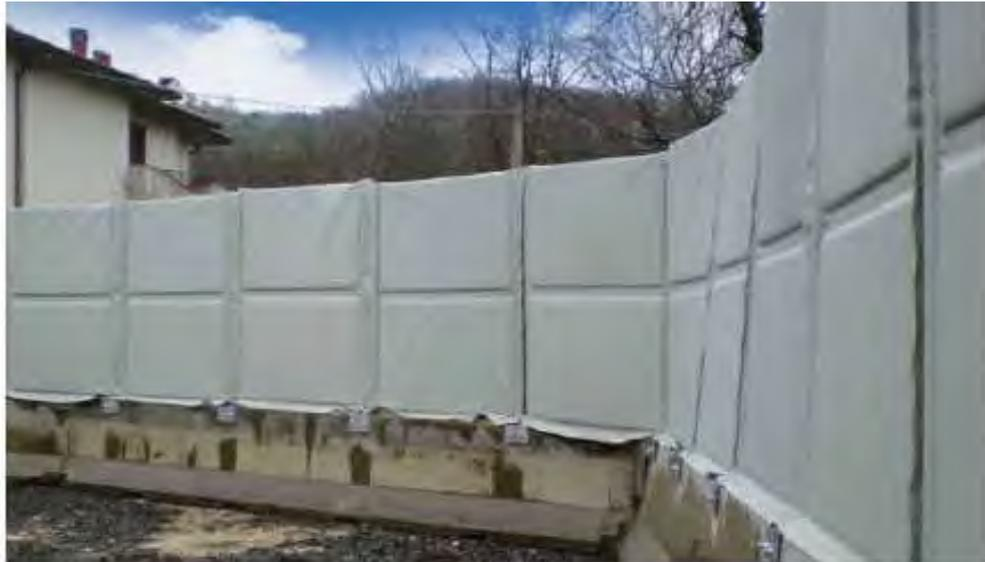
*Figura 9-5: Esempio barrile antirumore di cantiere mobili*
