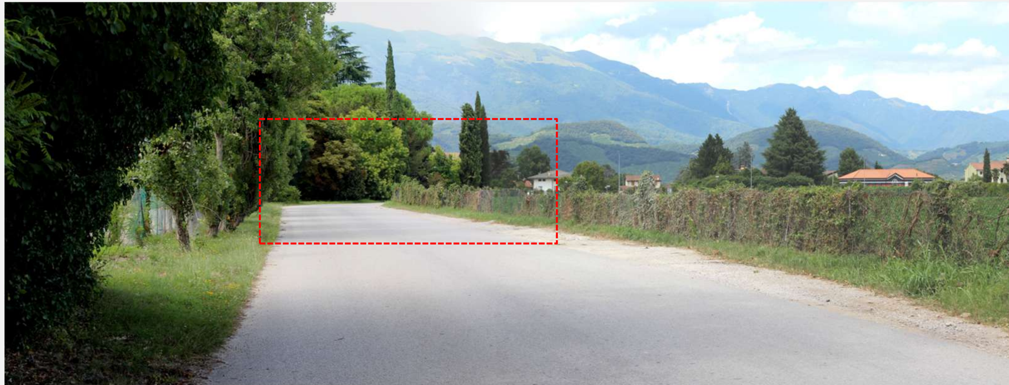
VISTA 19 Nord, Via Montello, Sottopasso
