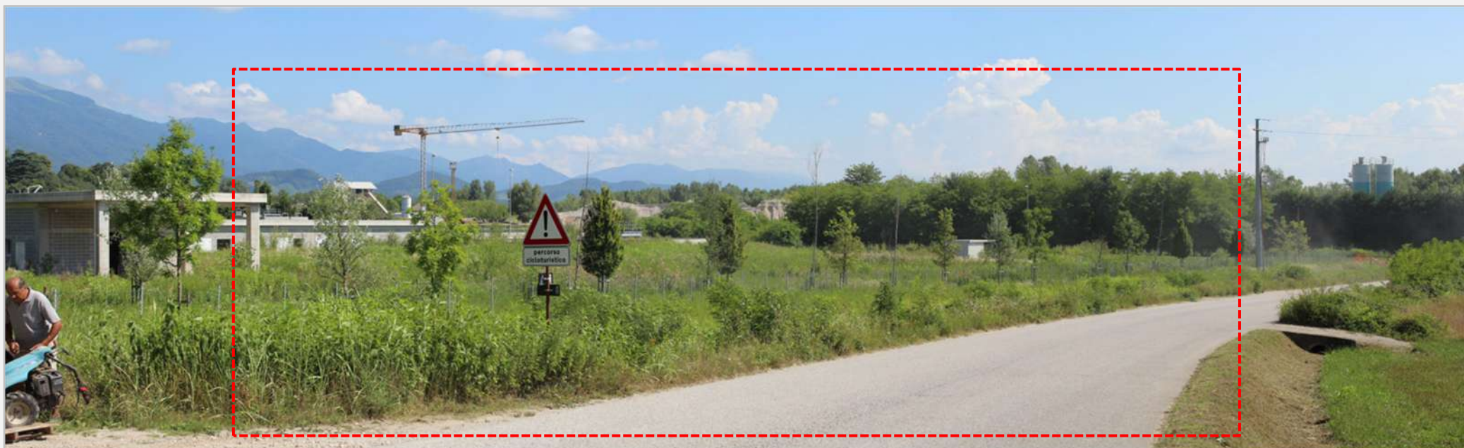
VISTA 07 Est Via della Ghiaia, nei pressi del Depuratore; inizio viadotto
