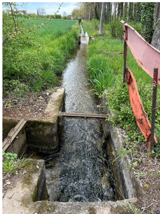
Figura 11: Fossato designato per lo scarico lungo via Cà Matta
