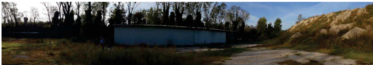
Foto 4: Tettoia metallica presente ai piedi del rilevato ferroviario
