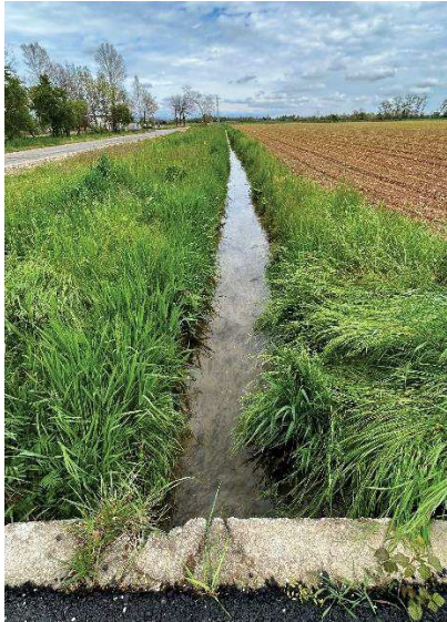
Foto 1: fossato lungo Via Cà Matta. Recapito dello scarico delle acque di dilavamento
