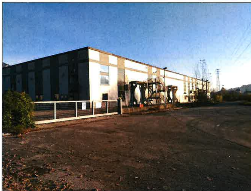
Foto 1 - Prospetto sud dell'ambito di intervento.
