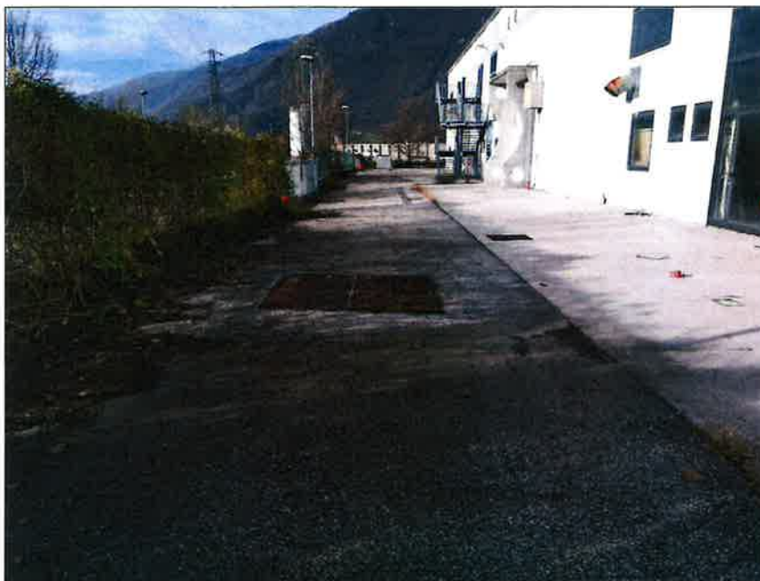
Foto 5 – Prospetto sud dell'ambito di intervento: particolare vasca antincendio.
