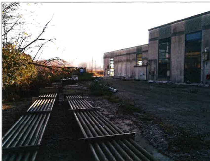
Foto 3 - Prospetto nord dell'ambito di intervento.
