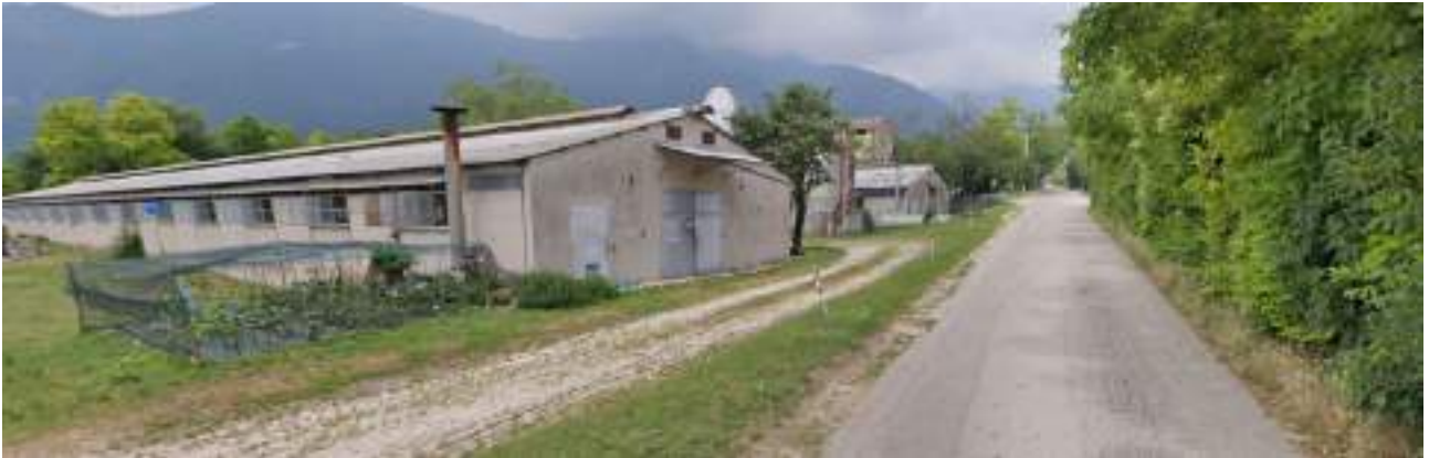
Vista dei fabbricati 1 e 2 esistenti oggetto di ristrutturazione
