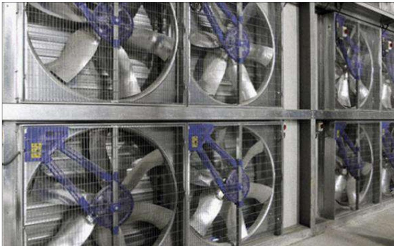
La movimentazione dell'aria è una delle soluzioni più efficaci per rinfrescare il capannone avicolo durante il periodo caldo: il flusso di aria permette di eliminare il calore eccessivo dall'animale producendo una sensazione di fresco (detto anche "effetto windchill"), ma anche per garantire il giusto approvvigionamento di ossigeno ed eliminare sostanze metaboliche come umidità, ammoniaca e diossido di carbonio.
