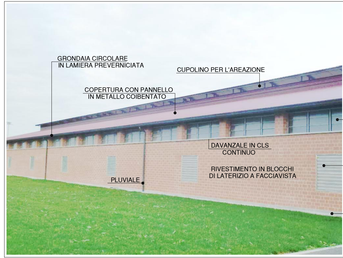
PARTICOLARE COSTRUTTIVO DI FACCIATA
