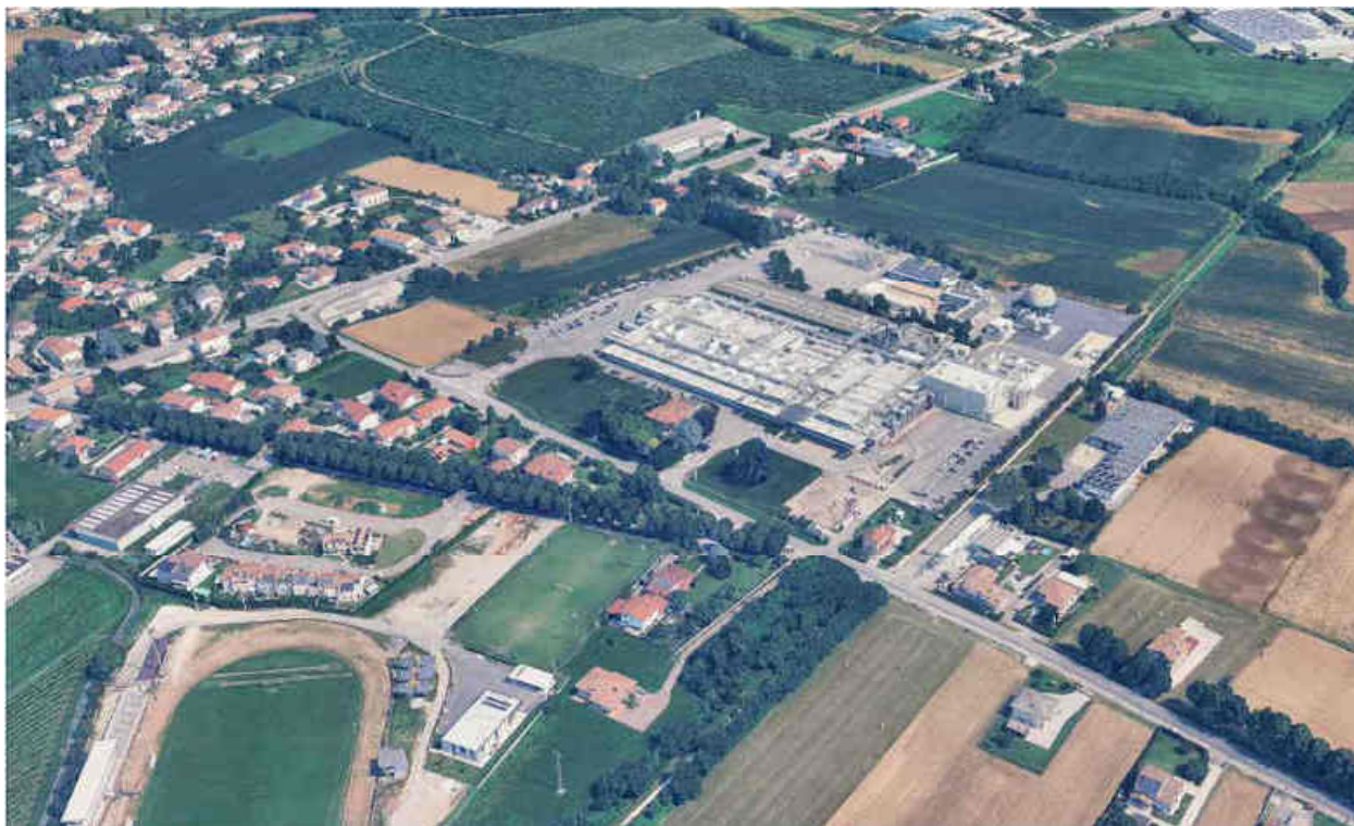
Figura 1.2 – Vista aerea del fabbricato produttivo
