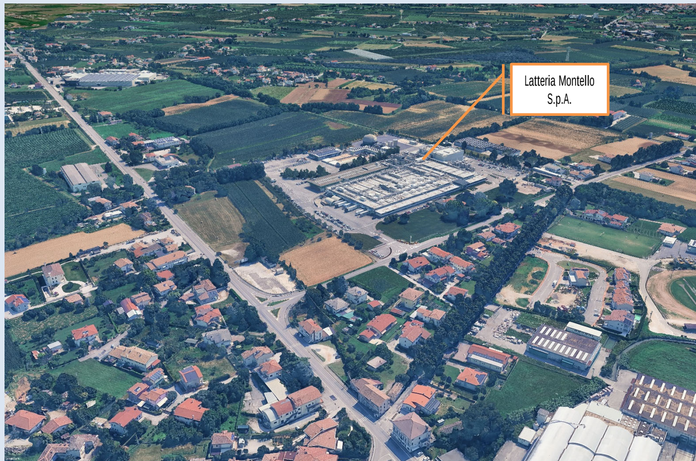
Figura 1: Vista prospettica dello stabilimento oggetto di intervento.
