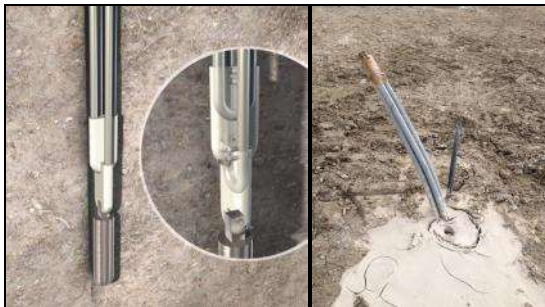
Figura 8 Sonda geotermica verticale del tipo a "doppia-U" (foto a sinistra, fonte REHAU) e dopo la messa in posto con cementazione (foto a destra, fonte A. Galgaro).
