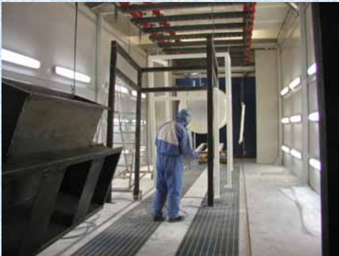
Cabina di verniciatura manuale
