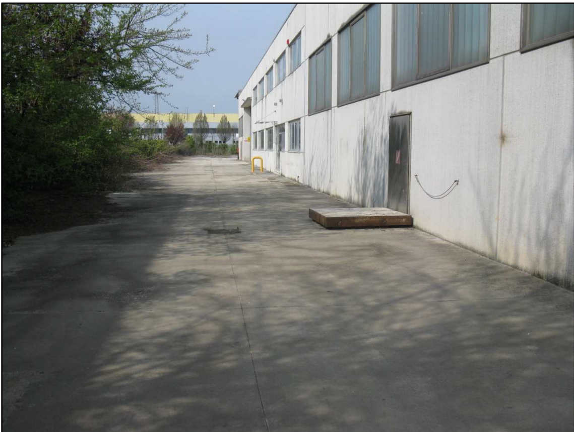
Foto n. 2: Ripresa da Sud-Ovest del piazzale esterno dello stabilimento esistente da riattivare.
