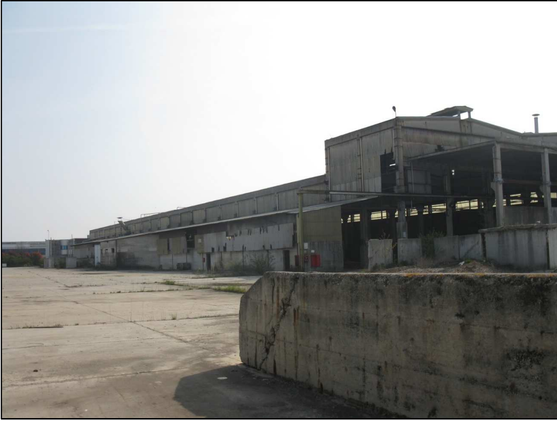
Foto n. 1: Ripresa da Nord-Est dello stabilimento esistente da riattivare.
